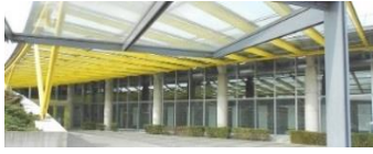
【テクノプラザ外来者駐車場】
